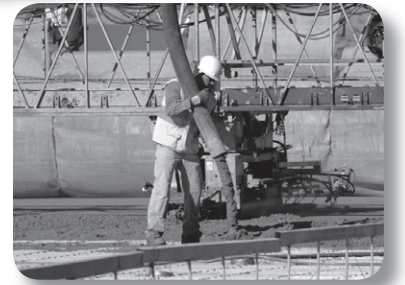
Concrete pour at Steamboat Hills Bridge.
